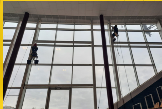
čištění skleněné stěny zevnitř, i to je naše práce
