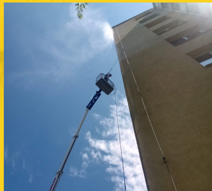
čištění fasády z pracovní plošiny
