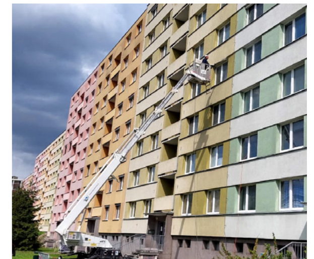
pracovní plošina nám pomáhá se špatně přístupnými místy
