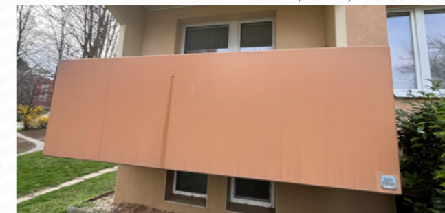
oprava rezivějící části ve stěně balkonu
