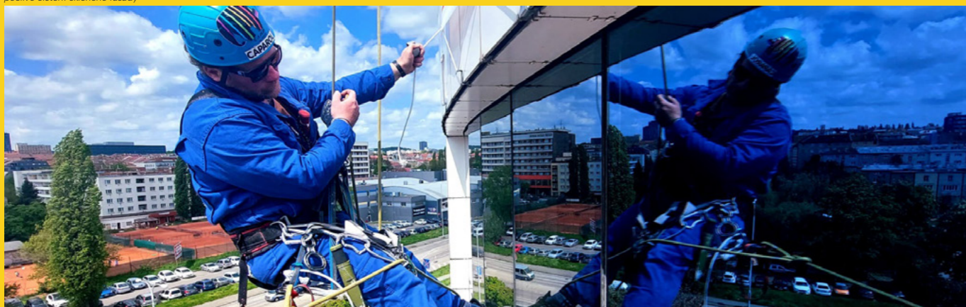
pečlivě čistění skleněné fasády
